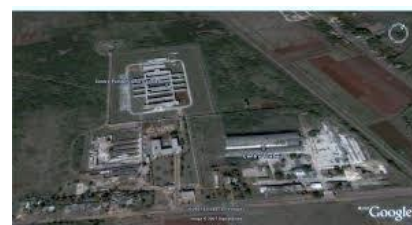
Vista aérea de la prisión Canaleta.
