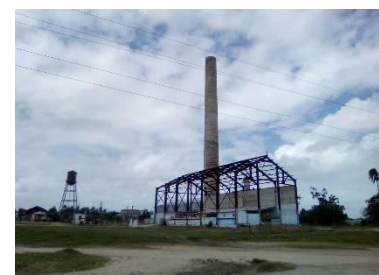
Almacén que estaba en construcción cuando desmantelaron el central.
